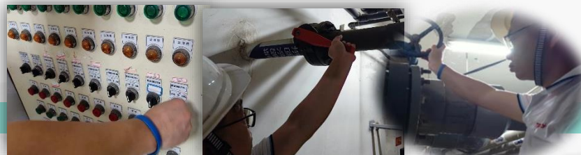
XA1: 关闭进水水泵，停止废水进入银预处理设施，将水打回流至暂留池，停止废水进入二期污水站
