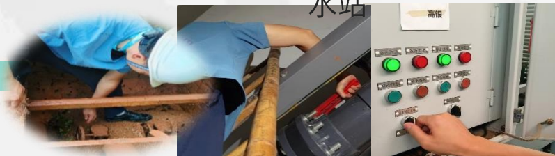
XA2: 关闭进水水泵，切换应急池阀门停止废水进入银预处理设施
